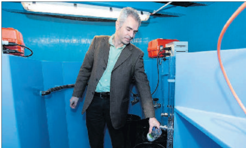
Daniel Urfer présente l'unité de traitement expérimentale à Porrentruy. L'eau y chemine par gravité pour subir différentes filtrations.
