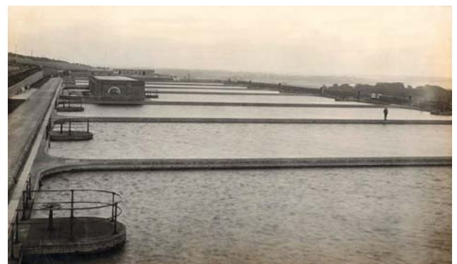
Fig. 1 Langsamsandfilter in Farlington, UK Filtre lent sur sable à Farlington, Angleterre
