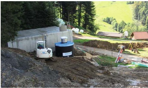
Fig. 2 Beispiel eines in der Schweiz installierten kls®-Filters Exemple de filtre kls® installé en Suisse
